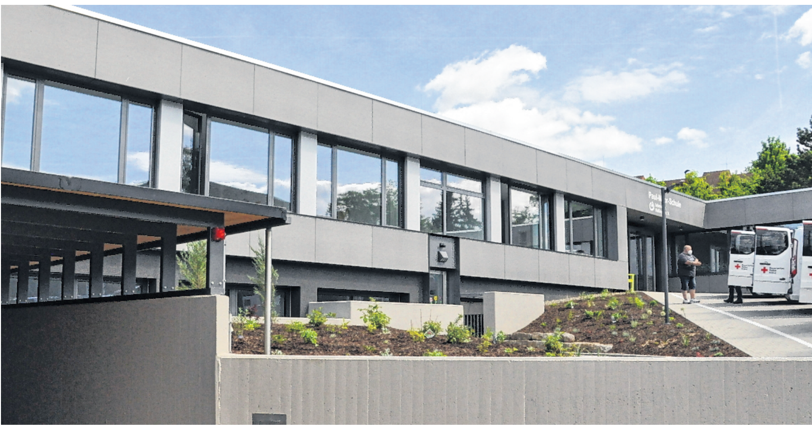
Die Paul-Moor-Schule in Sylbach wurde generalsaniert.
